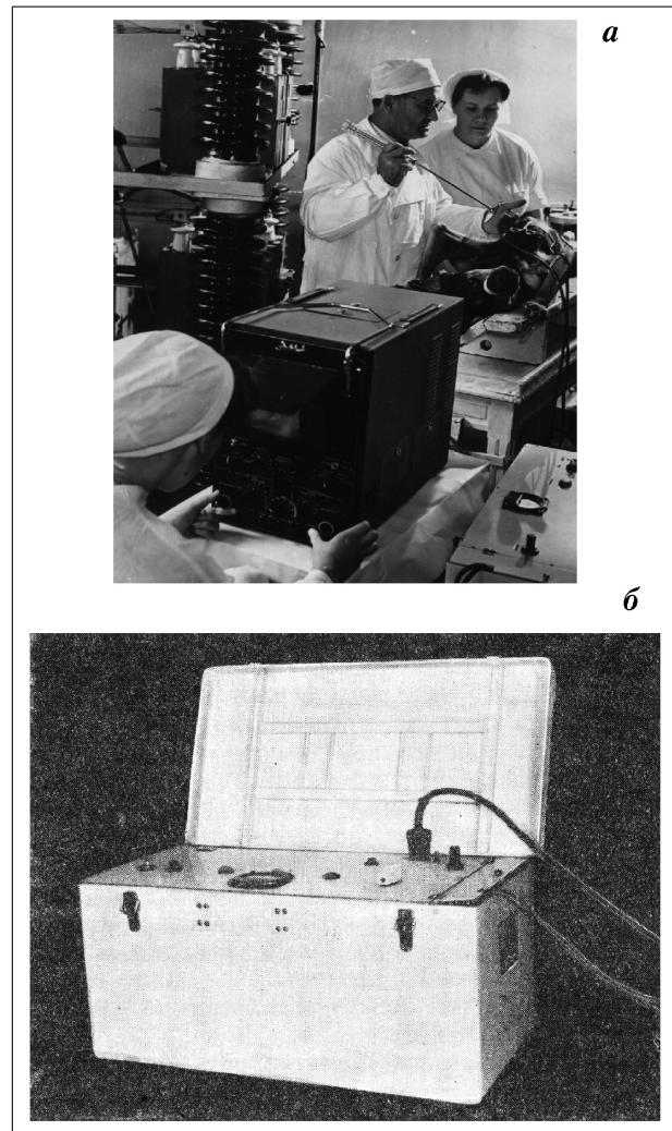
Рис. 1. а – Н. Л. Гурвич во время проведения эксперимента по дефибрилляции сердца импульсными разрядами, 1969 г. б – первый импульсный дефибриллятор ИД-1-ВЭИ; максимальная энергия, выделяемая на больного, ~190–340 Дж, масса около 30 кг.
